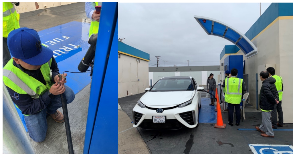
ホース取り付け作業
