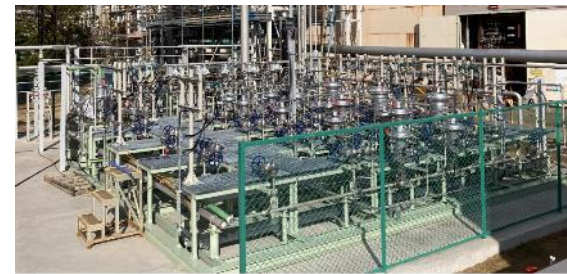
実圧燃焼試験用制御弁ユニット
