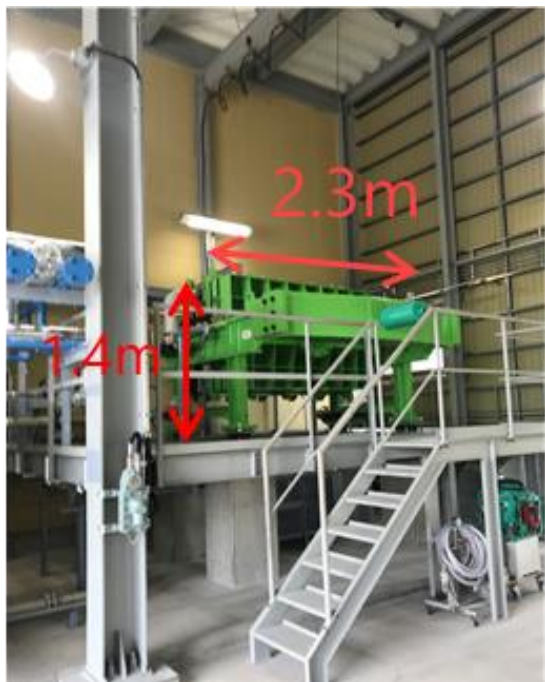
中型電解槽 (150kW級, 30Nm 3 /h)
